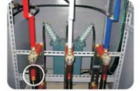
高壓保險絲過載異常溫度偵測
